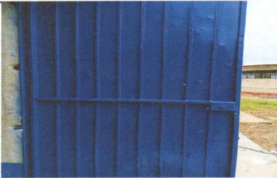
Foto 3: Sustrucion de chapas
