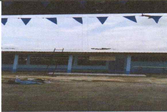
Foto 1: Sustrucion de lamina por lamina de aluzinc calibre 26
