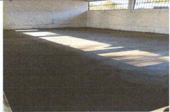
Foto 2: Sustrucion de piso de torta de concreto
